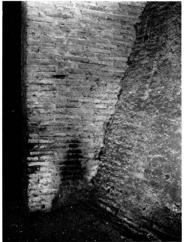
FIG. 35 - PISA, BATTISTERO - Appoggio sulla volta interna degli elementi trasversi, dettaglio delle murature.
