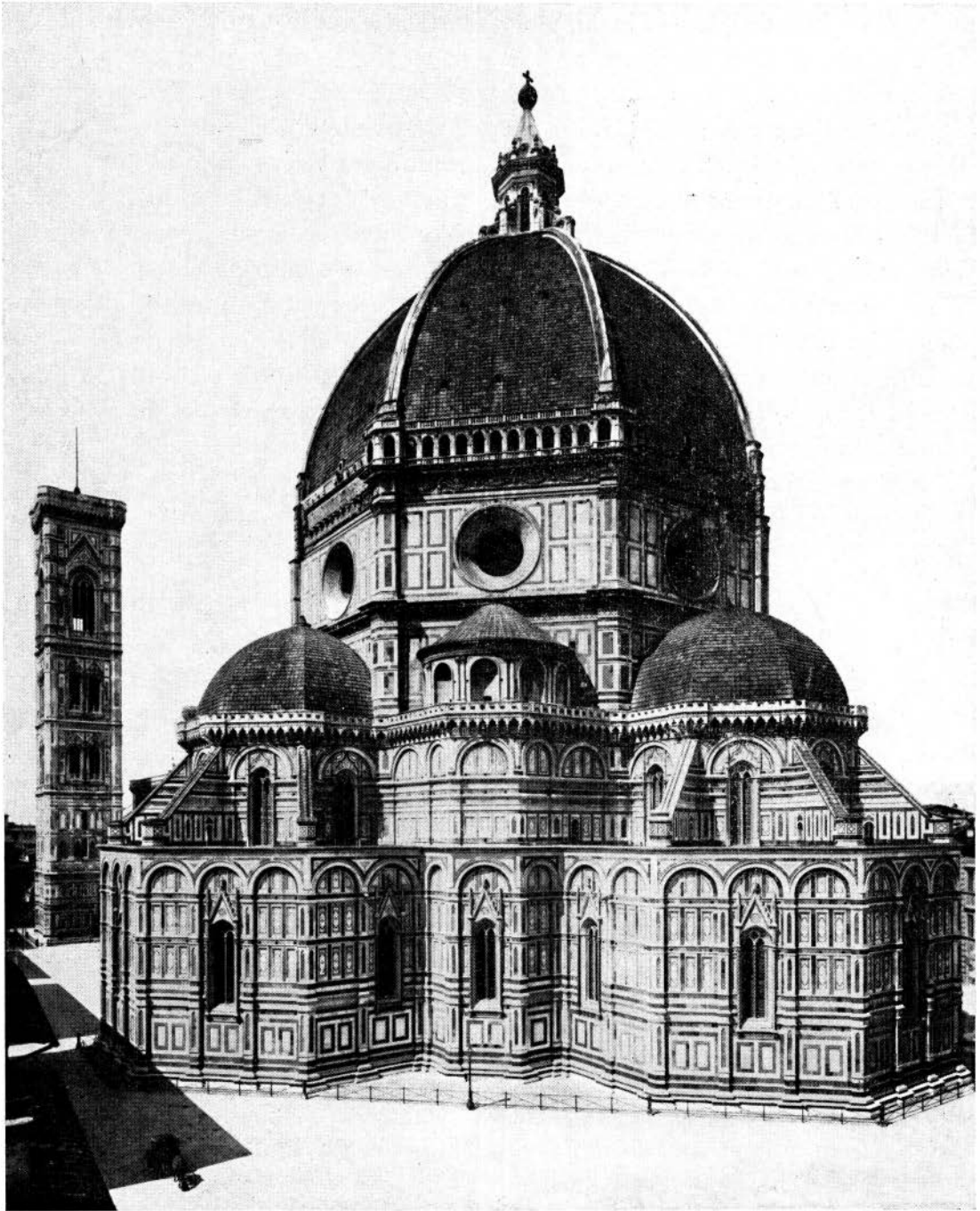
FIG. 48 - FIRENZE, S. MARIA DEL FIORE - Complesso absidale e cupola.
