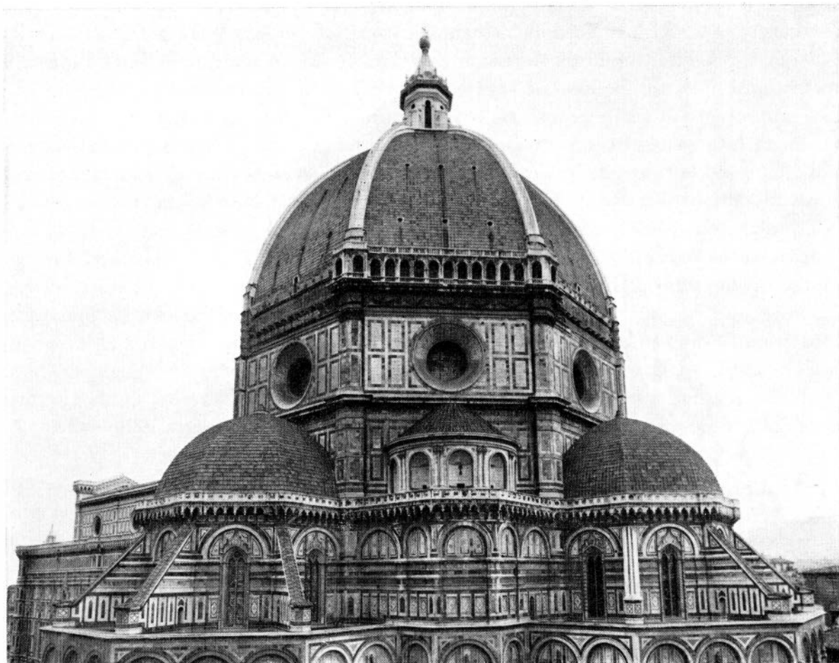
FIG. 43 - FIRENZE, CHIESA DI S. MARIA DEL FIORE - Sistema di cupole e coperture della zona absidale.
